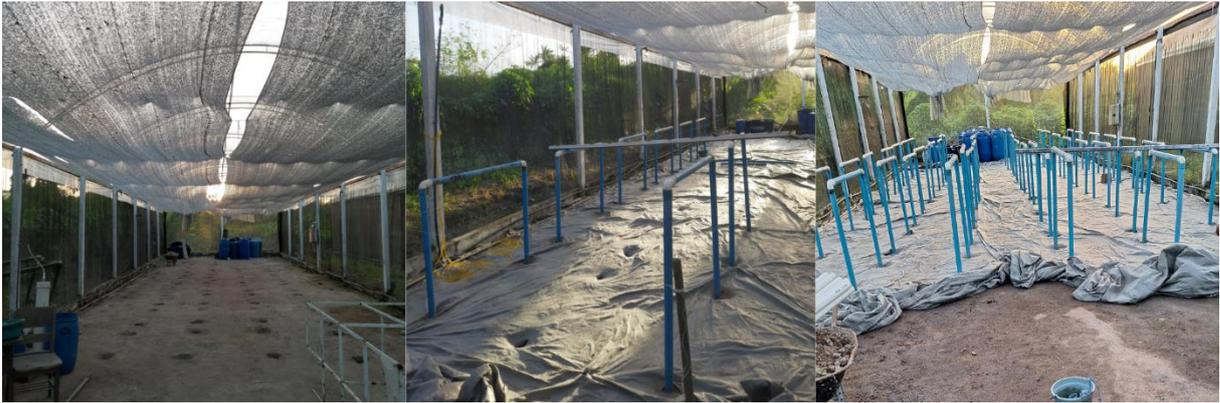
**Figura 7.** Processo de instalação dos cavaletes que compuseram as bancadas da hidroponia (perfuração do solo, traçado de um plano em nível, finalização da colocação dos cavaletes).
