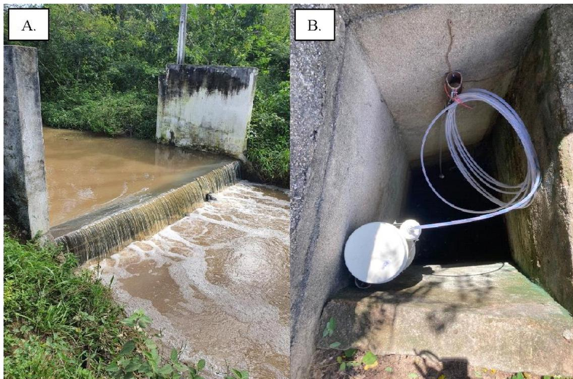
Figura 3. Seção fluviométrica (a) e sensor de nível da Ampeq® (b) na seção fluviométrica na bacia do Riacho Jatobá.
