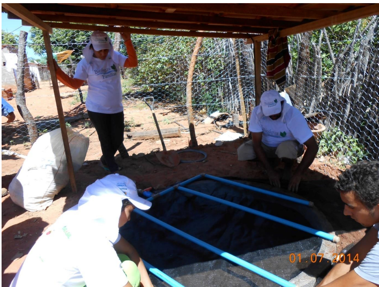
Figura 9. Detalhe do “chuveiro” que distribui a água cinza bruta na superfície do filtro biológico.
