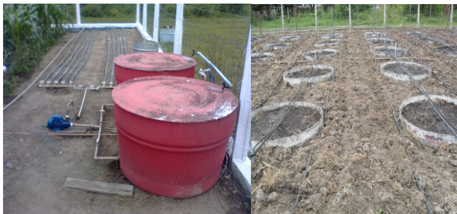
Figura 5. Tanques para preparo das águas salinas
