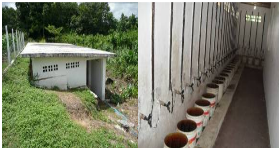
Figura 2. Casa de coleta da estação lisimétrica com os piezômetros individuais
