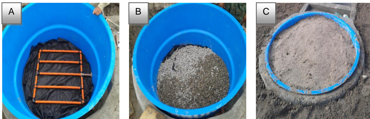
Figura 13 – Manta TNT e sistema de drenagem no fundo do lisímetro (A), preenchimento da camada de brita (B) e acomodação do solo dentro do lisímetro (C).
