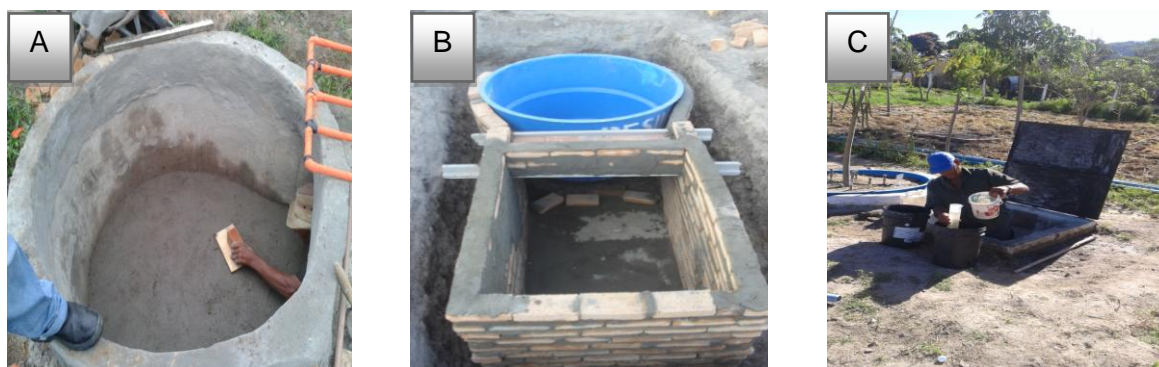
Figura 12 - Fases de construção do lisímetro de drenagem e do sistema de drenagem.
