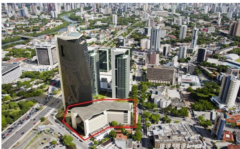
Figura 2. Localização do Edifício Garagem Empresarial Charles Darwin, da construtora Rio Ave Empreendimentos, no Recife, PE.
