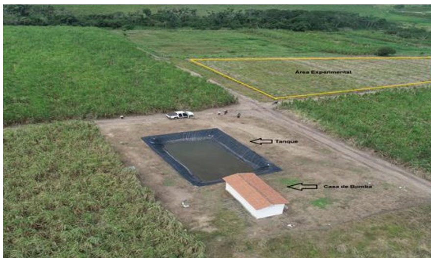
Figura 1. Área experimental, tanque de armazenamento de água para a irrigação e casa de bomba
