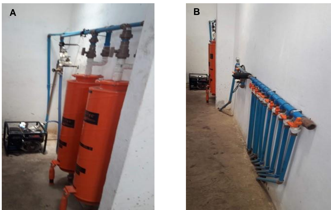
Figura 5. Ponto inicial do sistema de irrigação onde foram instalados uma bomba centrífuga, um sistema de filtragem e retro lavagem (Figura 5A), um sistema de injeção de fertilizantes do tipo Venturi e registros de esfera para o controle do fluxo (Figura 5B).
