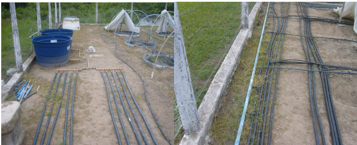
Figura 2. Detalhe da estrutura experimental. Instalações hidráulicas para aplicação das lâminas de irrigação em cada nível de dose de potássio
