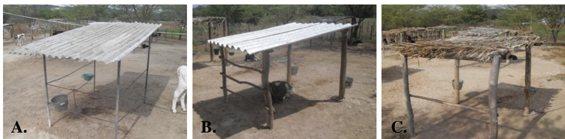
Figura 1. Abrigos individuais cobertos com telha de fibrocimento (A), telha reciclada (B) e palha (C)
