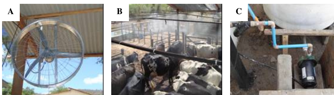
Figura 11 – Ventilador utilizado no SRAE* (A); detalhe da linha de nebulização (B); bomba d'água utilizada no SRAE* (C).
