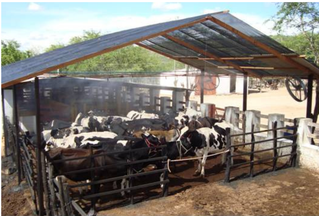
Figura 9 - Vista externa do curral de espera equipado com sistema de resfriamento adiabático evaporativo.
