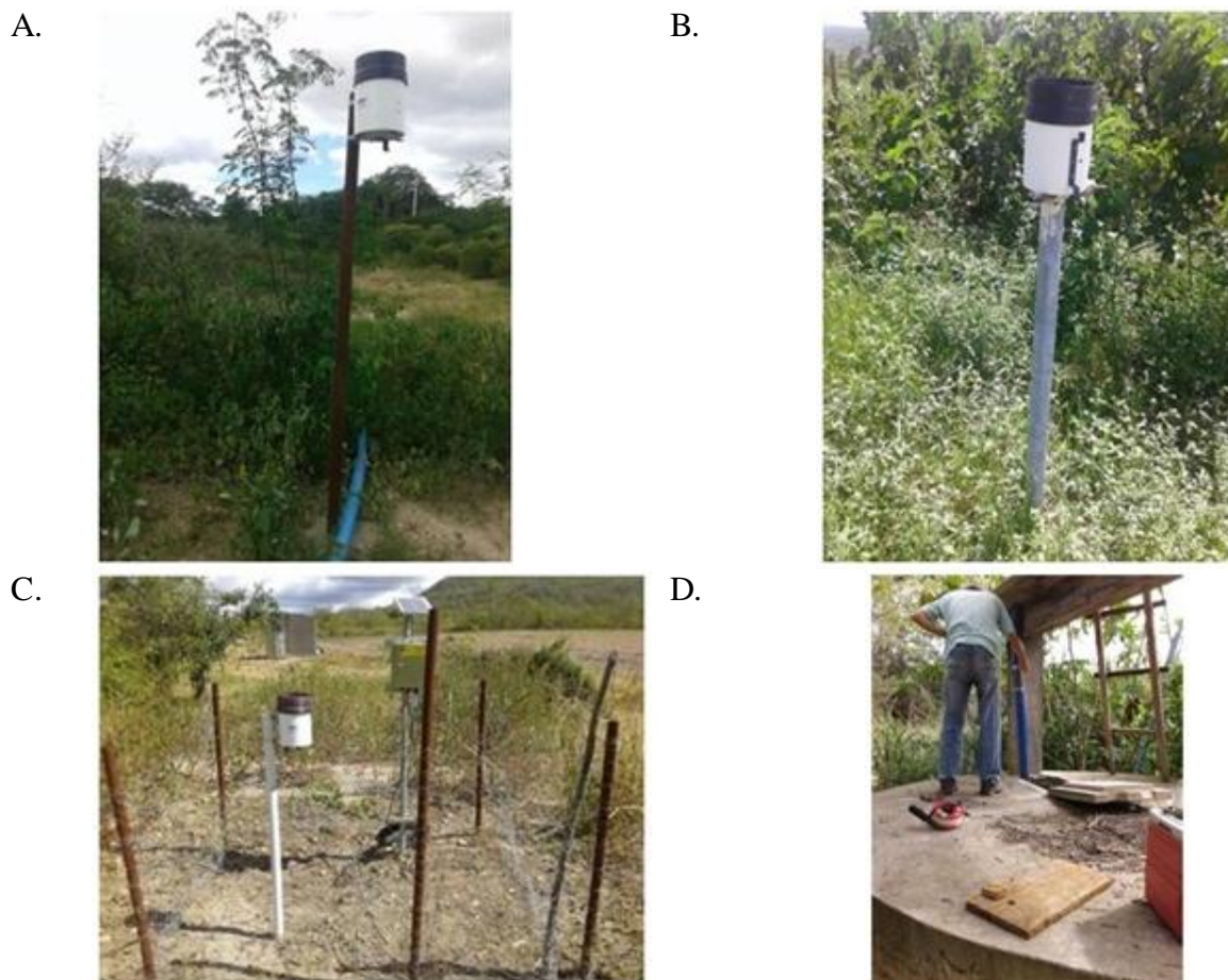
Figura 9 - Fotos dos pluviômetros e estação limimétrica instalados na Sub-bacia do riacho Mimoso e monitoramento dos níveis freático do vale aluvial.
