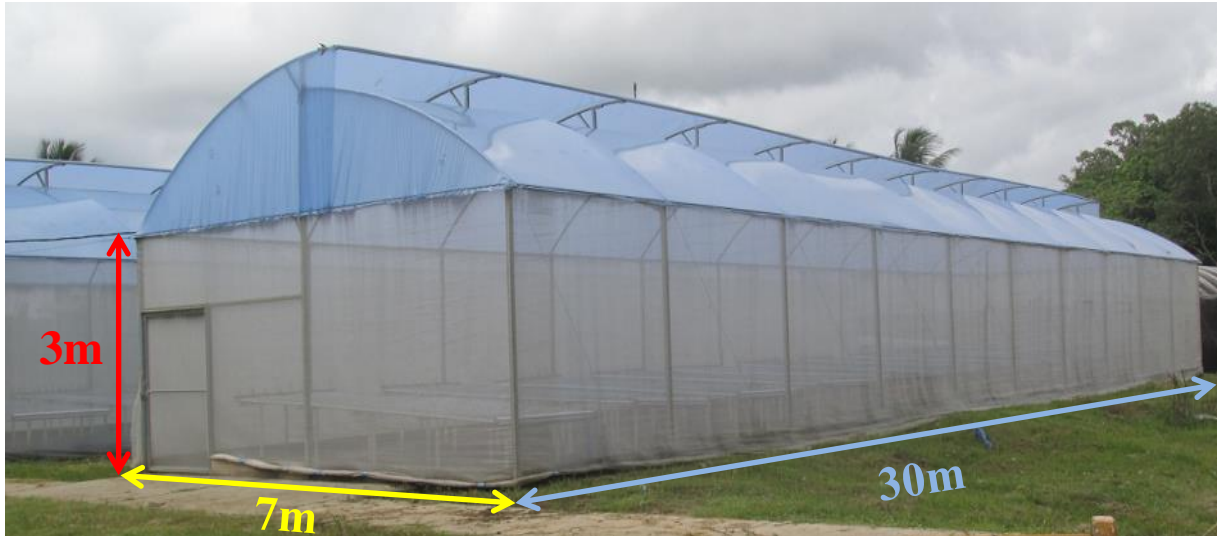
Figura 9 - Ambiente protegido utilizado na segunda etapa experimental.
