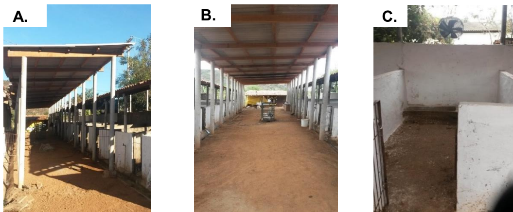
Figura 2. Vista externa da instalação (A); vista interna geral (B); vista interna da baia (C).
