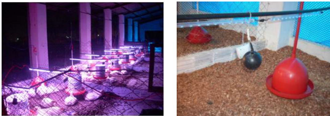
Figura 2. Vista interna do galpão e disposição do sistema de iluminação a base de LED
