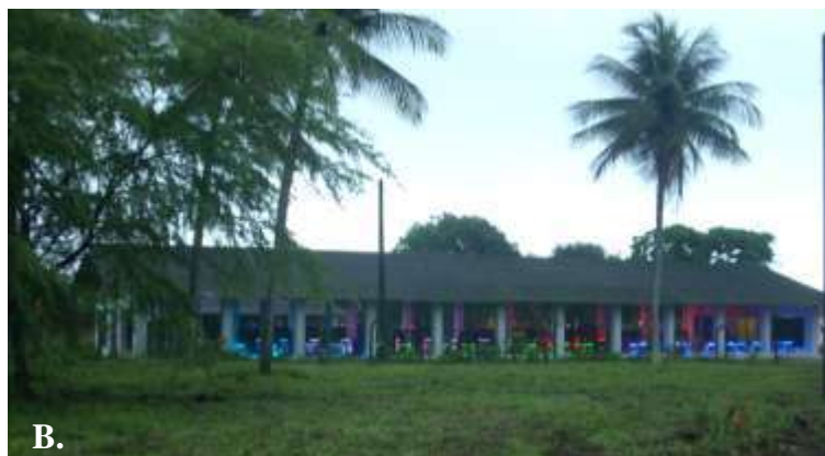
Figura 5 – Vista externa transversal (A) e longitudinal (B) do galpão utilizado para o alojamento das aves.
